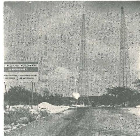
Le antenne del ripetitore di Bonaire che dispone di trasmettitori a onde medie e corte per circa 1000 kW complessivi di potenza. Porta anche i servizi religiosi di Trans World Radio fin nel centro degli Stati Uniti.
